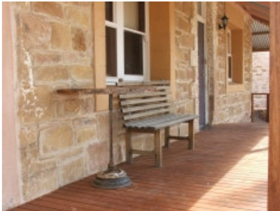
Bundaleer Cottage Veranda
